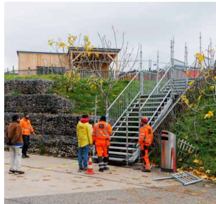
Les escaliers provisoires du parking du Martinet lors de leur installation. Testés durant trois mois, ils n'ont pas convaincu. ARCHIVES SIGFREDO HARO
